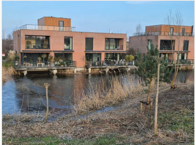
22) Vijver achterzijde Wetland: Onderhoud is uitgevoerd, er groeit riet onder de vlonders van de woningen.
